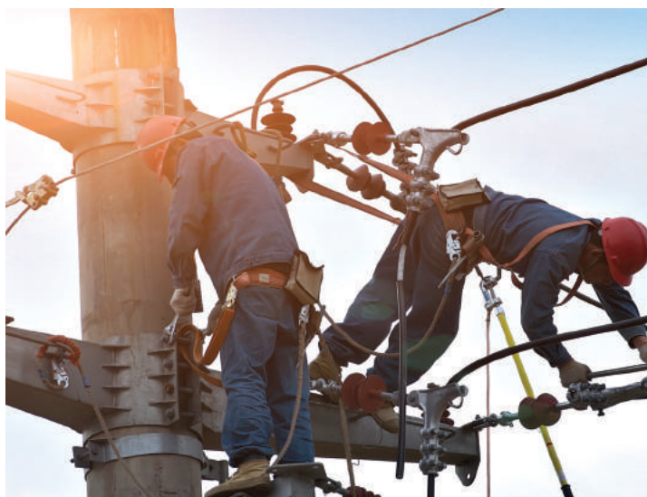
Imagen (c). Mantenimiento de torres de energía.
